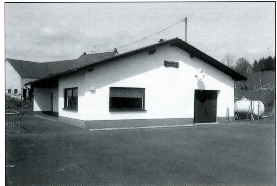
Umkleidegebäude am Sportplatz seit 1989
